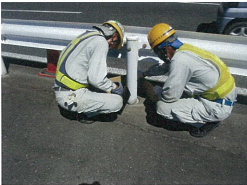
ポーソーシール T 充填状況
