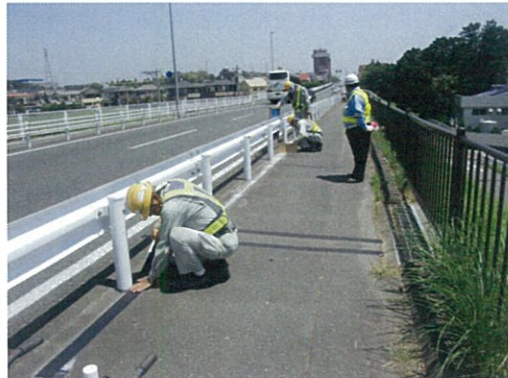
ポーソーシール TC-10 接着状況
