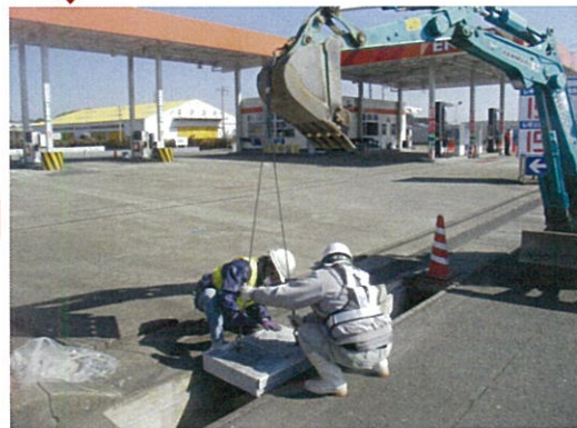
テンブルスリット蓋設置
