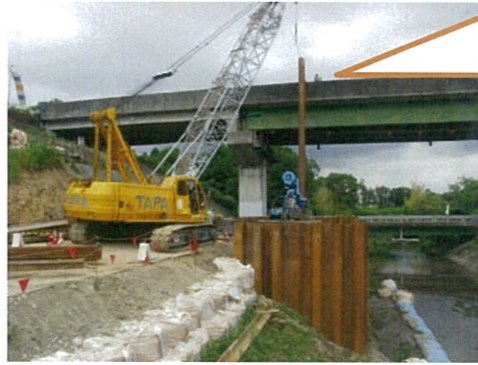
施工状況（鋼矢板打込み 圧入機）
