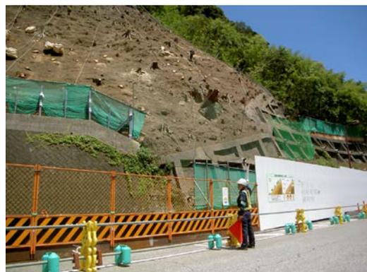
法面下で歩行者、車両の安全確保のため監視人による合図状況
