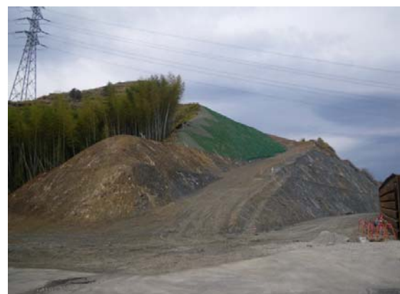
掘削完了全景
