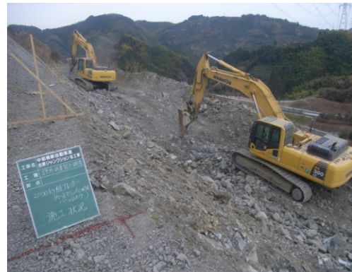
ブレーカー作業
