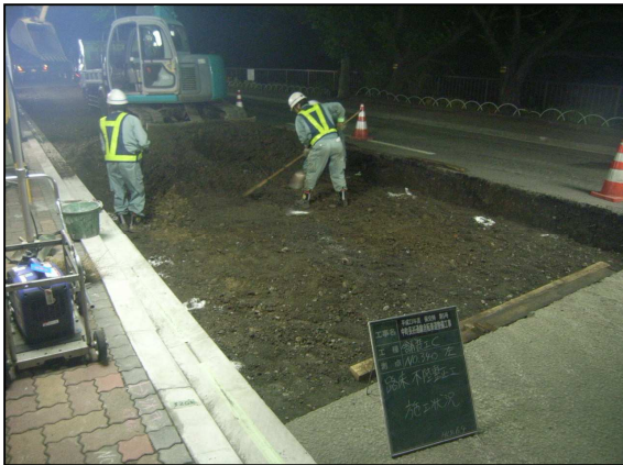
下層路盤施工状況
