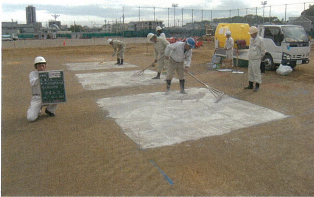
現地試験 セメント系固化材散布状況
