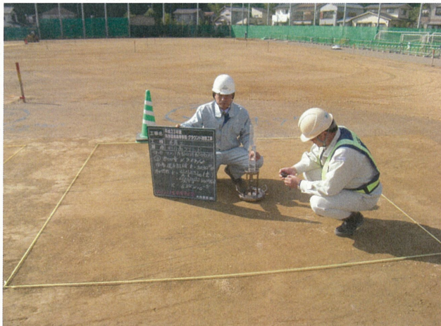
現地試験 透水試験状況
