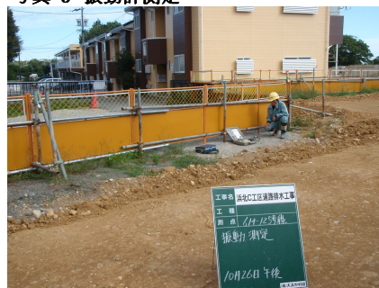
写真-3 振動計測定
