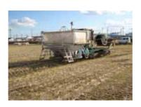
一部完成については、水甲·集水管施工を2班に増やし作業分担を明確にしてドレンレイヤー機械の待ちがないよう施工した。もみ殻の確保は、発注後すぐに地元農協に連絡しもみ殻の搬入があればすぐ連絡をもらうようにした。もみ殻の保管場所については、屋根付きの倉庫を借りる事ができ、農協から連絡が入ればいつでも運搬できる状態にした。
