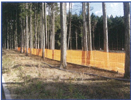
オレンジネットの設置
