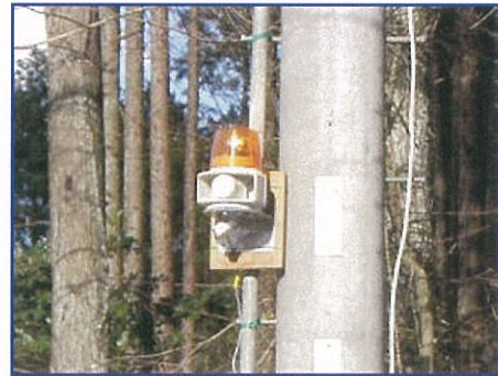
センサー式回転灯の設置
