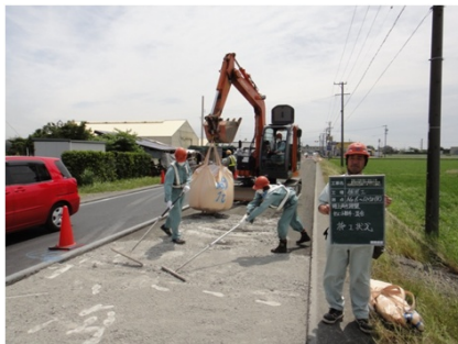
セメント散布状況
