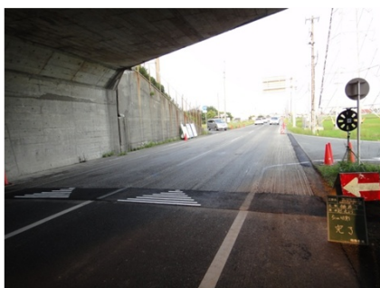
取壊し完了(1次)開放状況
