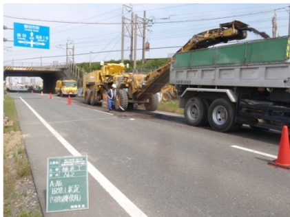
舗装版取壊し状況(1次)
