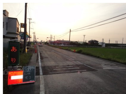
取壊し完了(1次)後開放状況
