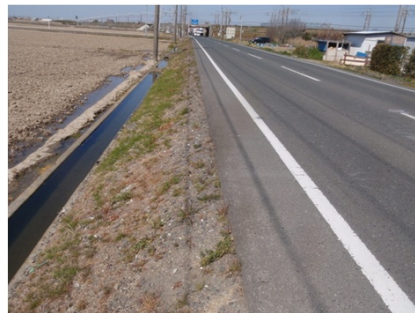
路肩部の状況
