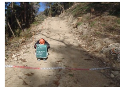
仮設進入路設置完了
