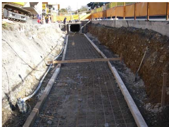
図-4(メッシュ鉄筋配置)
