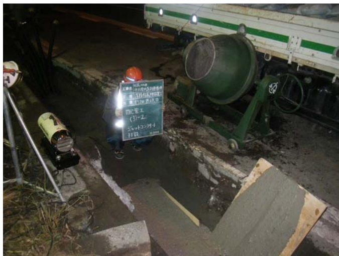
図-8(ジェットコンクリート打設状況)
