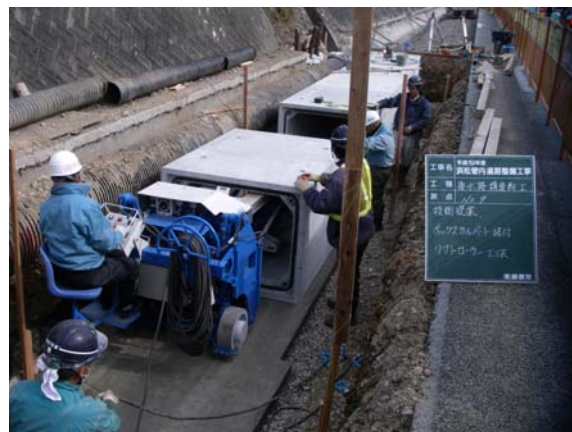
図-5(リフトローラ施工状況)
