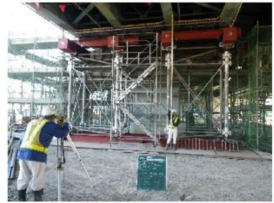
各桁にかかる荷重は端主桁で800kN、中間主桁で400kNとかなり大きい荷重のため、基礎地盤の強度の検討が必要でしたが、今回はベントが増し打ちしたフーチング上にあるため基礎の沈下は心配ありませんでした。
