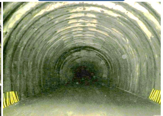
支保工設置区間
