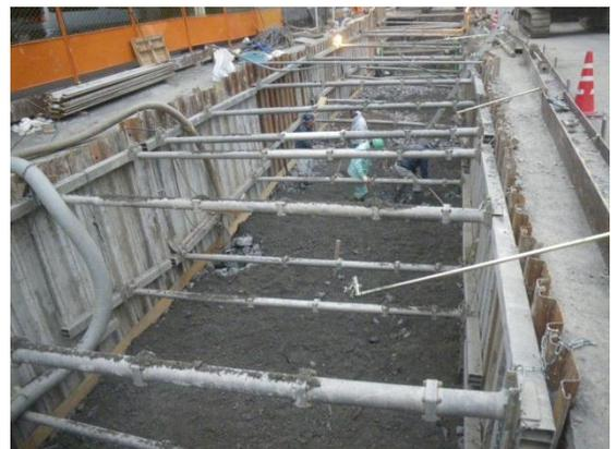
図一 3 φ75の多孔管、水中ポンプ設置状況
