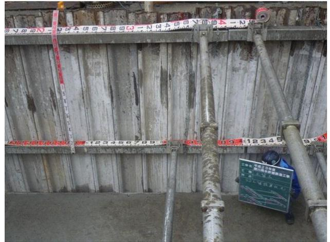
図一 2 アルミ製水圧式土留め支保工設置状況
