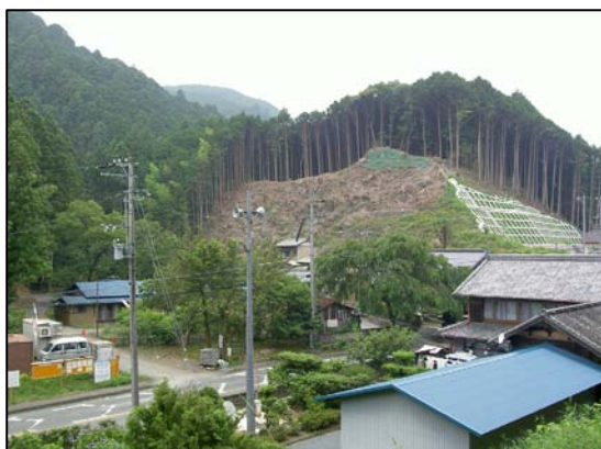
着手前写真（支障木撤去後）
