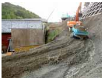
仮設防護柵設置後の掘削施工状況
