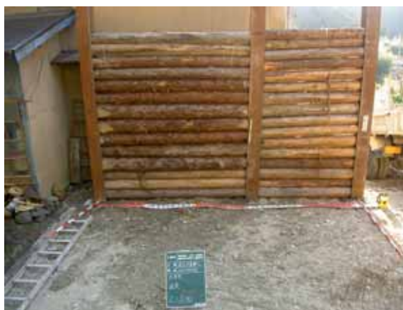
参考写真 H鋼＋横木構造
