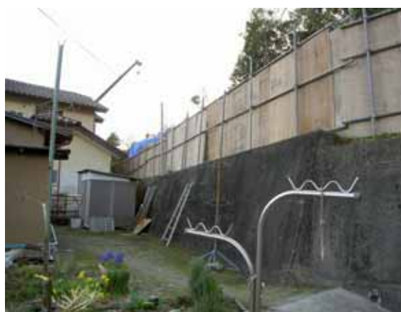
参考写真 単管パイプ＋合板構造
