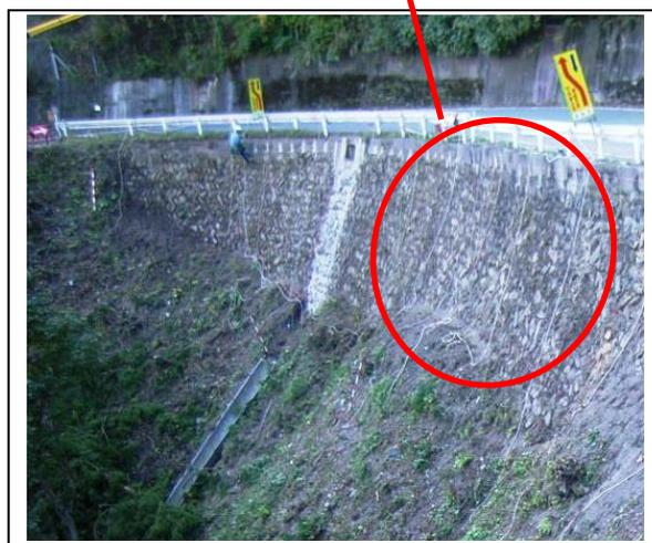
H 6 基礎杭部では、コンクリート基礎設計で 施工の場合、既設壁 (根固めコン) を、撤去する構造となる。根固めコンを撤去した場合、工事背景でも述べたように生活道路の確保が困難となる。
