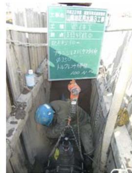
写真-1 フランジレスバタフライ弁取付
