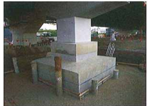
鋼管杭完了時
