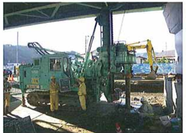
NSエコパイル工法・桁下施工状況
