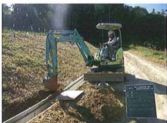
幅狭バケットによる張コンクリート床堀状況
