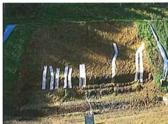
エンドレンフィルター設置完了全景
