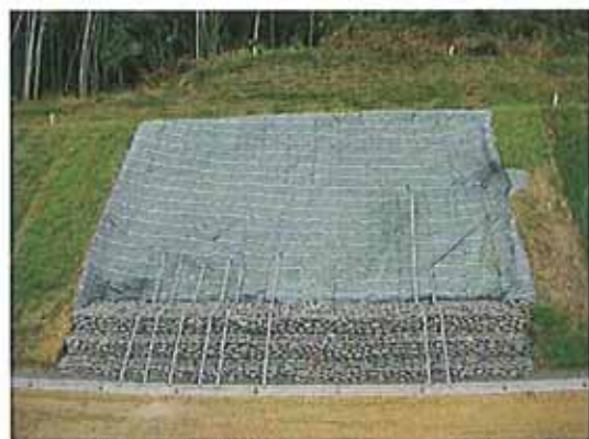
亀甲金網付き植生マット施工完了全景
