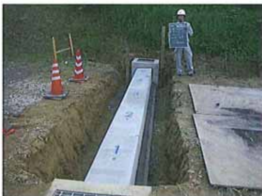
横断函渠工 PU-BOX 300A (T-25) 据付完了
