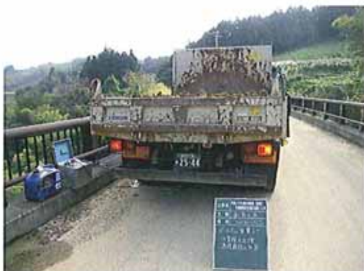
ポータブル重量計による総重量測定状況
