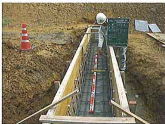
現場打ち横断側溝工(T-25) 配筋確認状況
