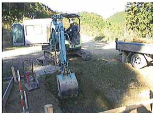
リッパ付きバケットによる改良土床堀状況
