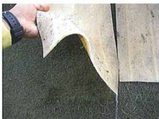
エンドレンフィルター機能確認
