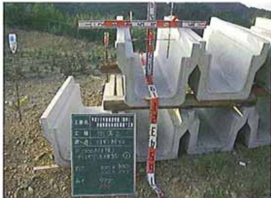
使用材料検収 PU300A(3種) L=1m/本
