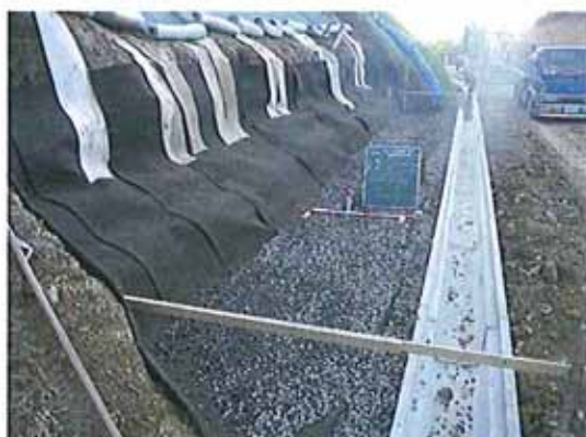
単粒碎石による床拵え完了
