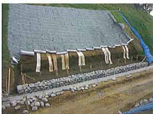
2段目 吸出防止材(ヤシ繊維)敷設
