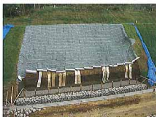
2段目 単粒碎石による床拵え完了
