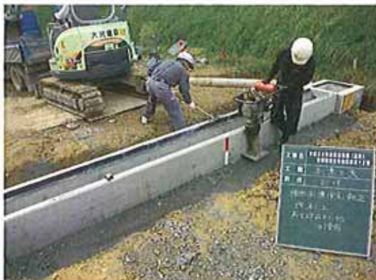
現場打ち横断側溝工
