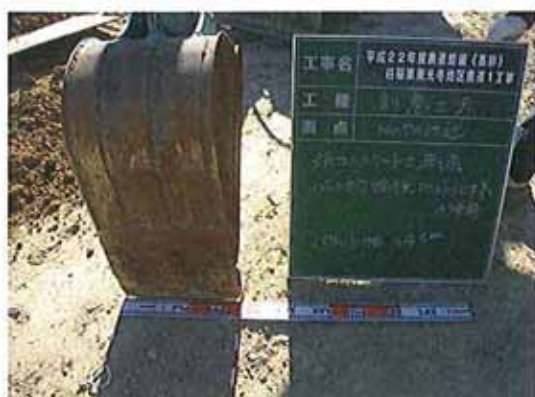
0.1m 3 BH幅狭バケットの幅 34cm
