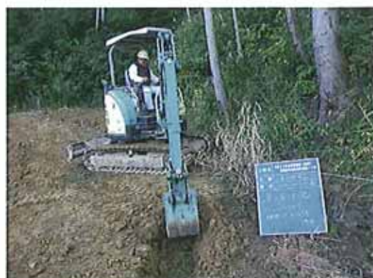
幅狭バケットによる集水暗渠工床堀状況
