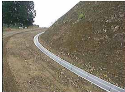
急カーブにおける短尺製品布設完了状況
