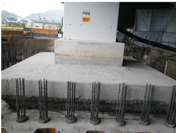
図-5 既設フーチング補強前
