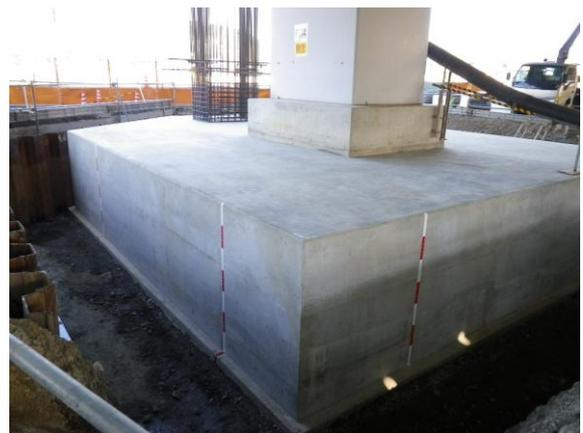
図-6 補強コンクリート打設後
