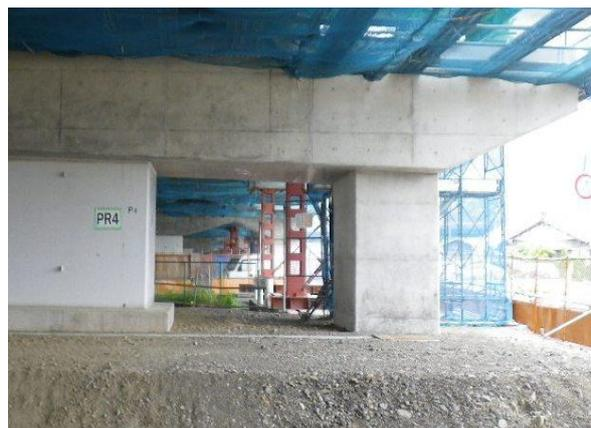
図-8 梁部打設完了
