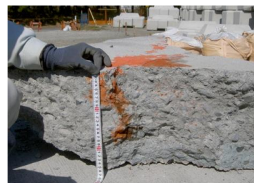
クラック深さの調査
