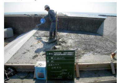
被膜養生剤の散布
