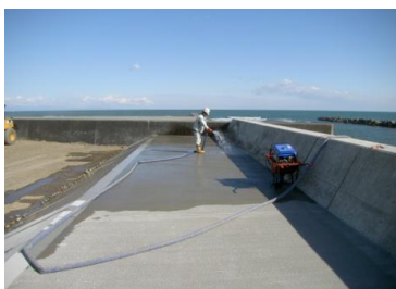
施工後 散水養生
