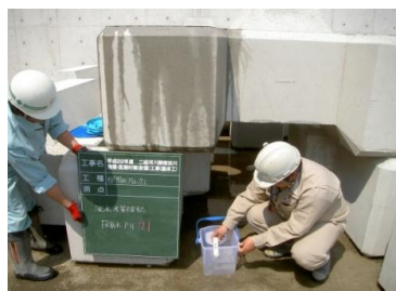
据付前・流水採取pH測定
