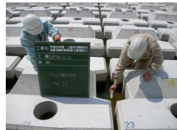
据付後・溜水採取pH測定
