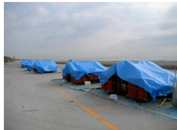
施工時養生(11月)
