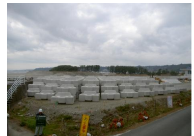
仮置き養生(1月～3月)
