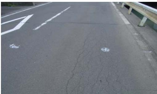
現状調査を行った結果、補修区間のクラック状況は区間全体に発生しているが中規模的である。わだち掘れについては、存在していない。
