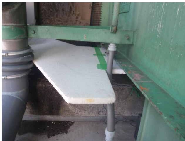
設置状況確認 (写真-3)
