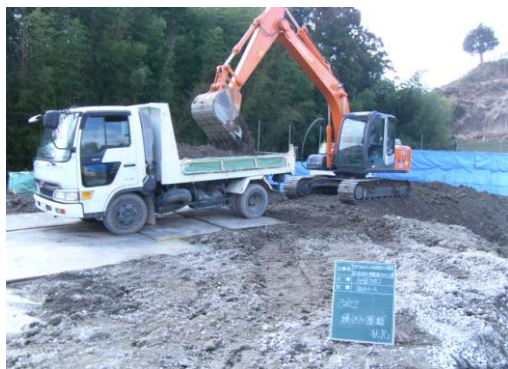
攪拌盛土材積み込み
