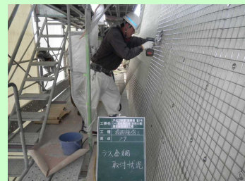
ラス網取付状況
