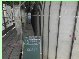
主筋固定状況
