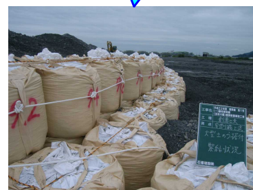
大型土のう緊結状況
