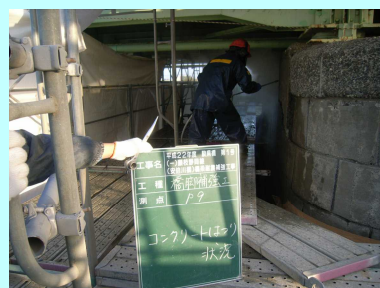
コンクリートはつり状況 (240MPa、380/min)
