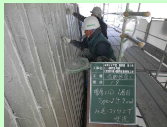
コテ仕上げ状況
