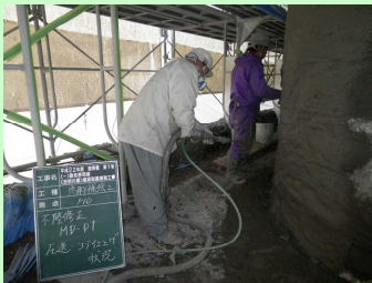
不陸修正状況
