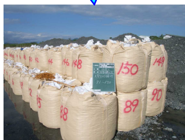
大型土のう設置状況
