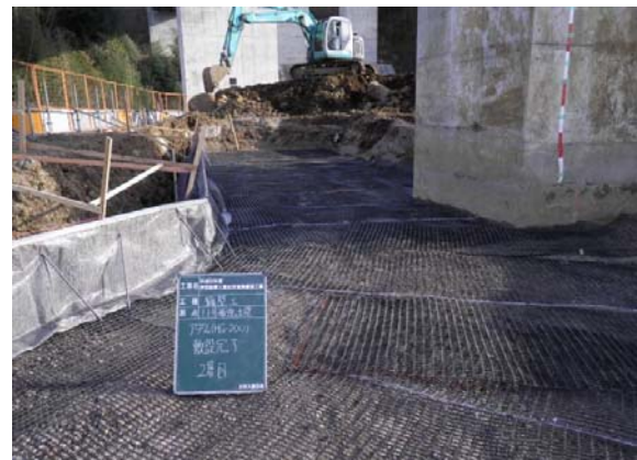
アダムウォール敷設状況
