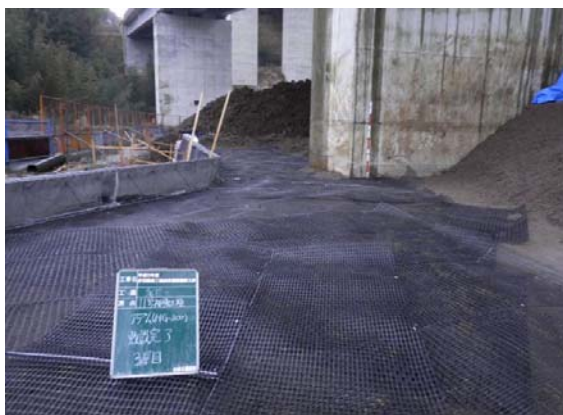
アダムウォール敷設状況
