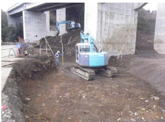
掘削・床付状況
