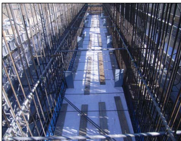
打継ぎ目の養生
