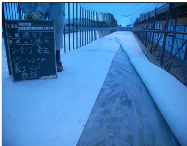
打継ぎ目の養生
