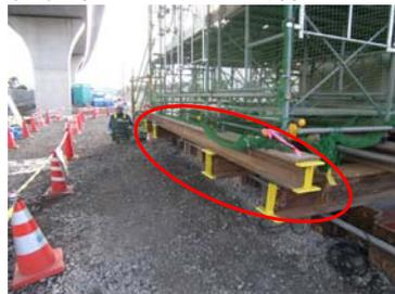
大型重機の使用頻度が高いため、供用されているI期線橋脚への接触を未然に防ぐ為に離隔の明示や、H鋼の角等、接触すれば怪我をする危険がある箇所への明示を行った。
