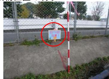
開口部のような危険な箇所において、ロープ等で立入禁止措置を行った後、蛍光のリボンテープで目立つ様に明示した。又、作業通路や資材置場、埋設物位置を明確にし、意識向上を図った。
