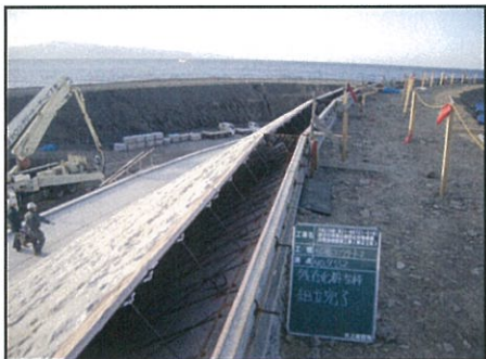
多面体にして施工した残存型枠
