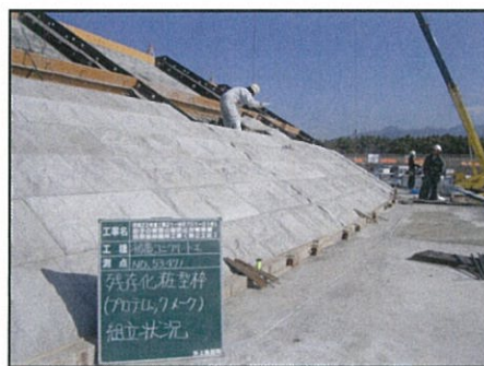
型枠据付状況(専用吊り具使用)
