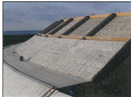
多面体にして施工した残存型枠
