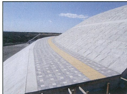
多面体にして施工した残存型枠
