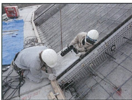
型枠据付状況(専用吊り具使用)
