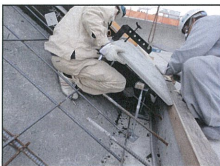
支え用「束」使用状況
