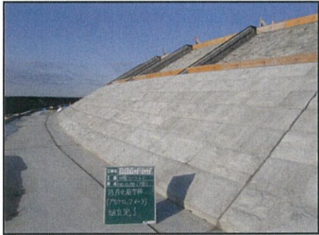
多面体にして施工した残存型枠
