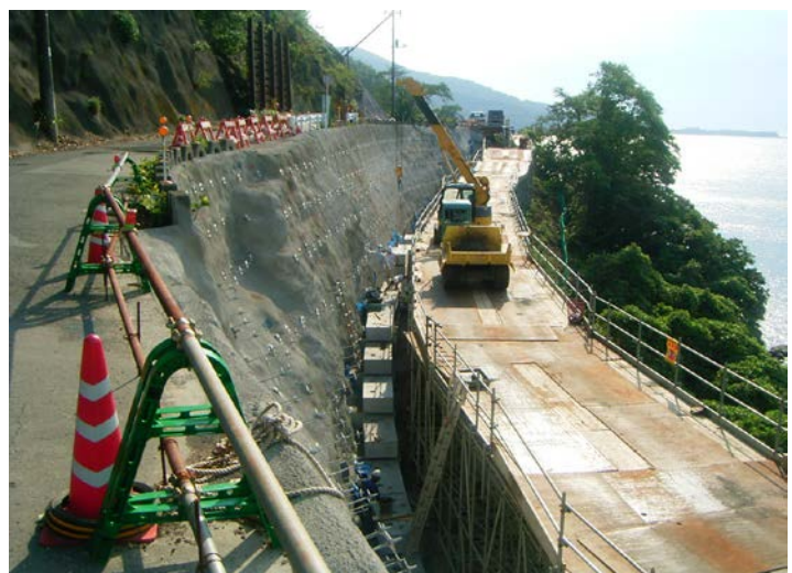
SPC施工状況
