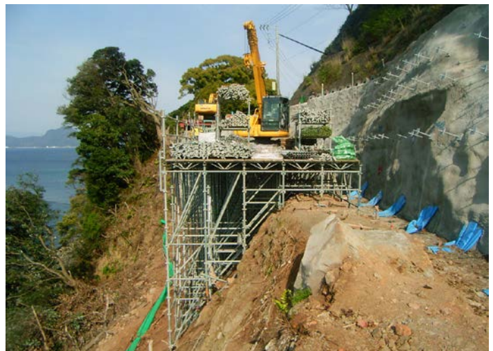
システム構台設置状況
