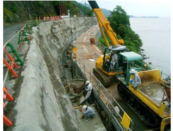
間詰、埋戻しコンクリート打設状況
