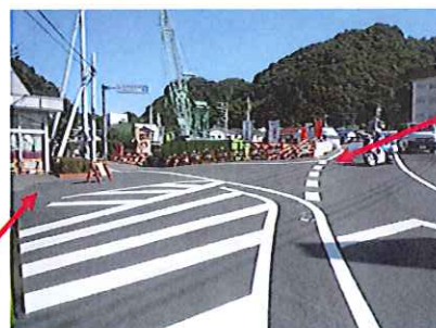
乗入部の下層路盤材による一時緩和
