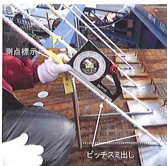
1:1.0勾配、計画高よりピッチスミだし、測点標示
