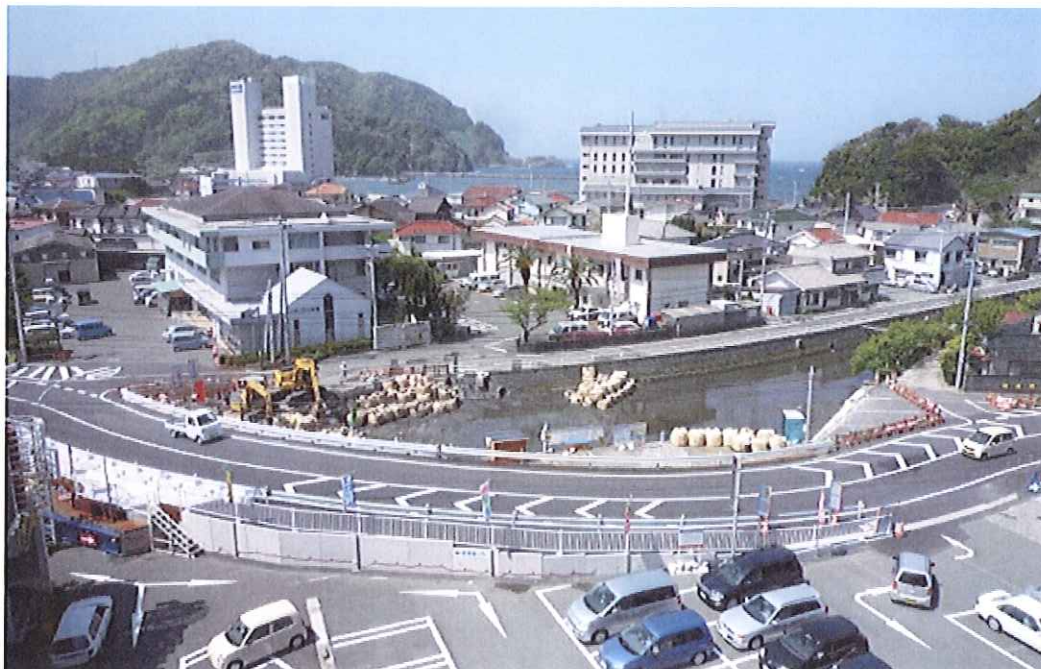
仮設道路通行状況
