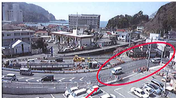
起点側の路床盛土及び終点側のオーバーレイ舗装による切り替え
