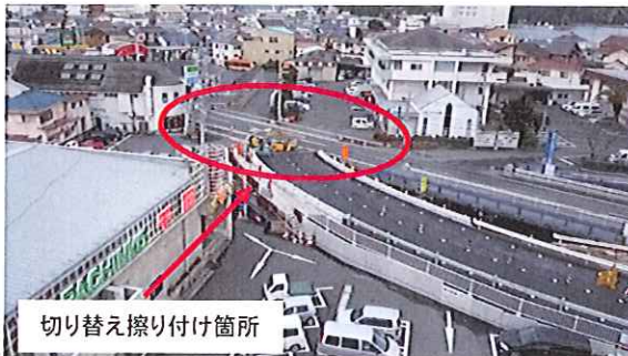
起点側 (路床盛土)
