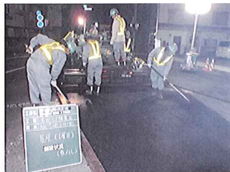
終点側オーバーレイ舗装状況
