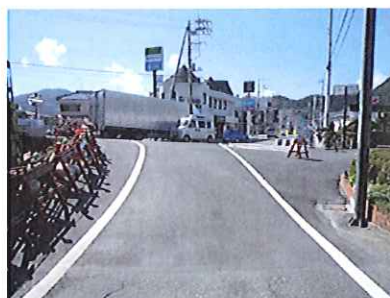
起点側の路床盛土及び終点側のオーバーレイ舗装による切り替え
