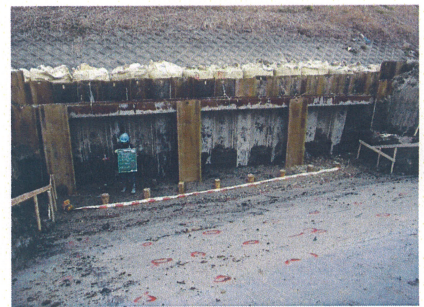
川表翼壁工 木杭施工完了
