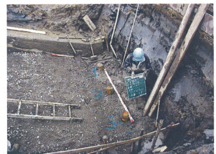
階段工 木杭 施工完了
