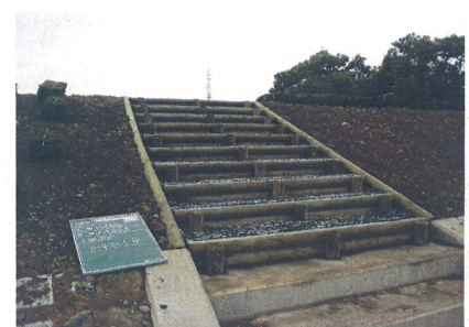
階段工 木柵階段 施工完了
