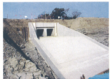
川表翼壁工 出来形全景
