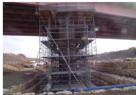
大型土のう設置状況②
