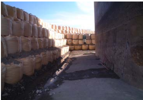
大型土のう設置状況①
