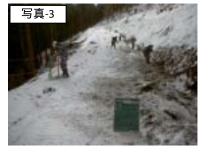
人力除雪作業
