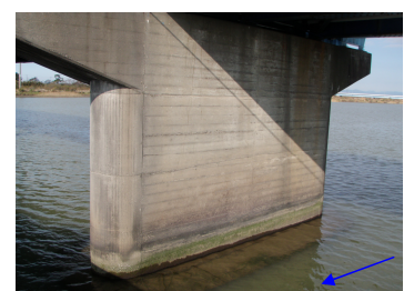
P4橋脚 東京側
