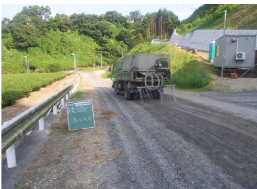
ホコリ対策散水状況
