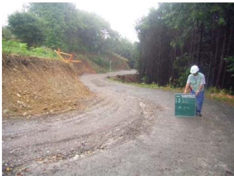
仮設道路拡幅完了
