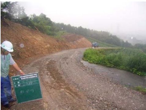
仮設道路拡幅完了
