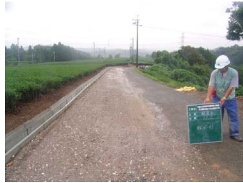
ホコリ・雨天時対策・敷 RC 材状況
