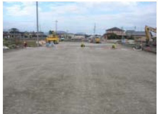
改良土盛土～完了全景
