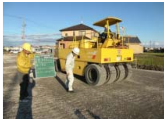
プルフローリング試験
