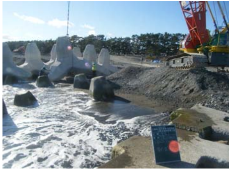
【ブロック据付状況(突堤内側)】
