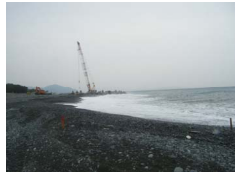
【ブロック据付状況】 (外周部を先行した結果波浪時でも作業が可能)
