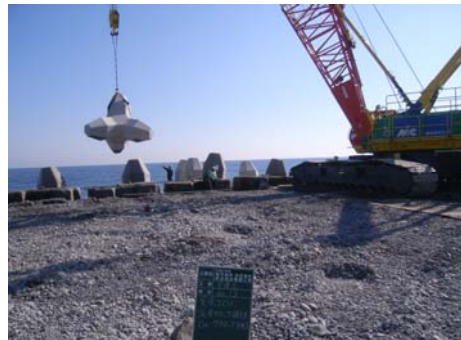
【ブロック据付状況】
