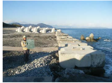
【クレーン足場保護用仮設ブロック設置完了】
