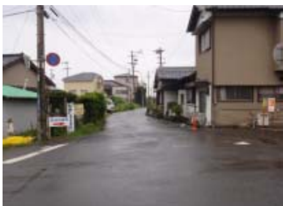
道路幅員の減少箇所
