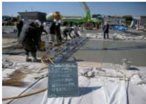
簡易フィニッシャー併用人力施工状況
