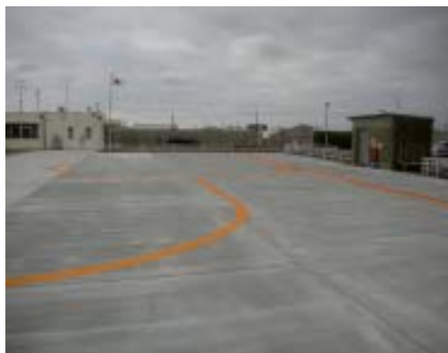
完 成 (コンクリート舗装)
