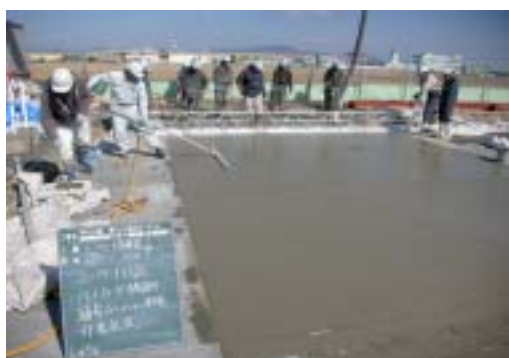
簡易フィニッシャー併用人力施工状況
