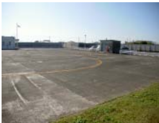
着手前 (半たわみ性舗装)
