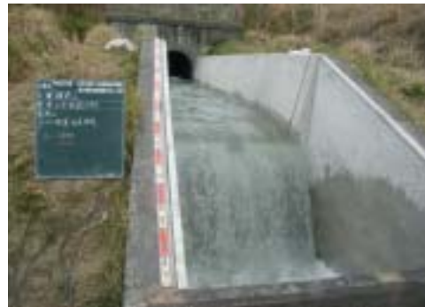
施工期間中での断水・通水状況
