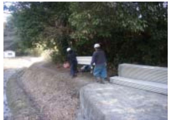
人力による資材運搬状況
