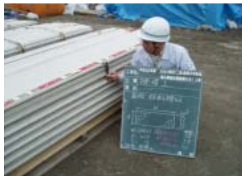
使用材料検収立会い状況
