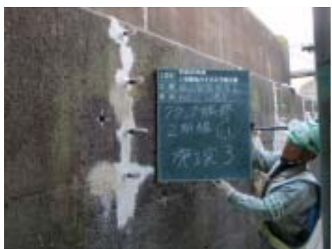
上部クラック注入完了
