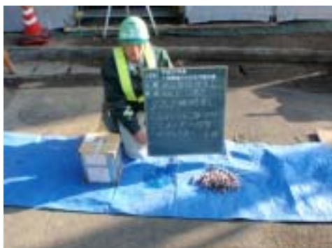
使用材料(クラック注入材)
