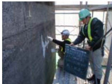
シール及び取付パイプ設置状況
