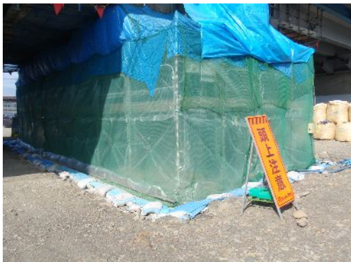
施工箇所(橋脚)をシートで覆う
