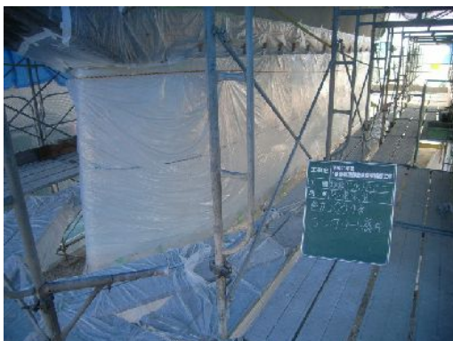
急激な乾燥を防ぐ養生シート
