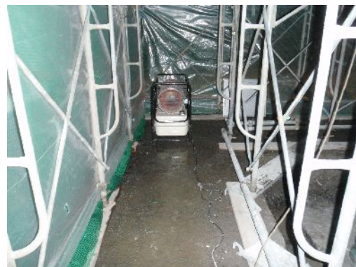
施工箇所をジェットヒータで保温
