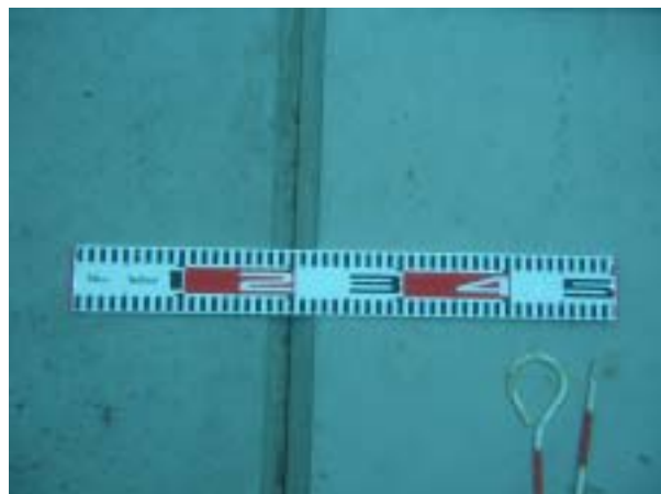
写真-3 完成 根固ブロック据付完了 天端部 目地
