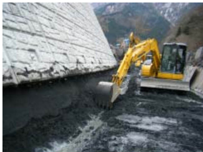
図-2 シルト層掘削状況
