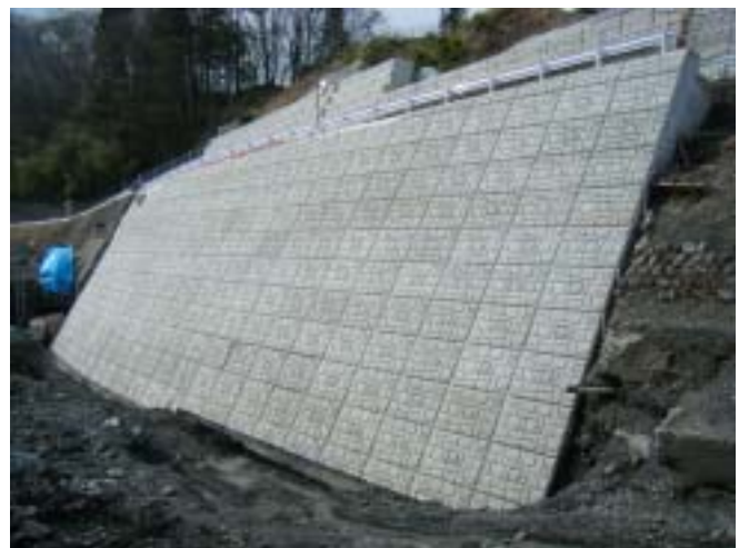
図-1 逆巻き工法、PANWALL 工法完了時
