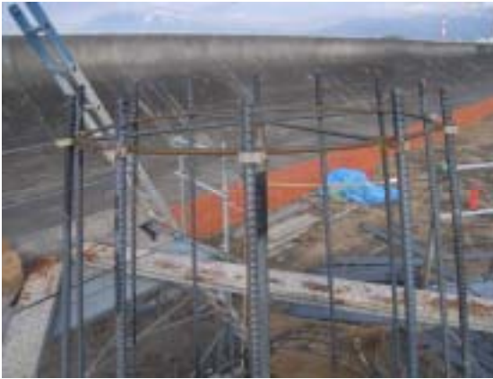
写真-2 脱着式の鉄筋差し込み定規(頭部)
