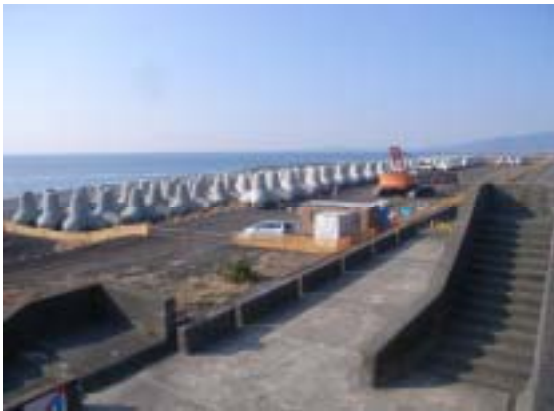
写真-1 ブロック製作ヤードの状況
