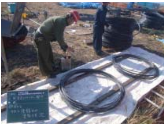
写真-4 曲げ加工部にたいして防錆材塗布
