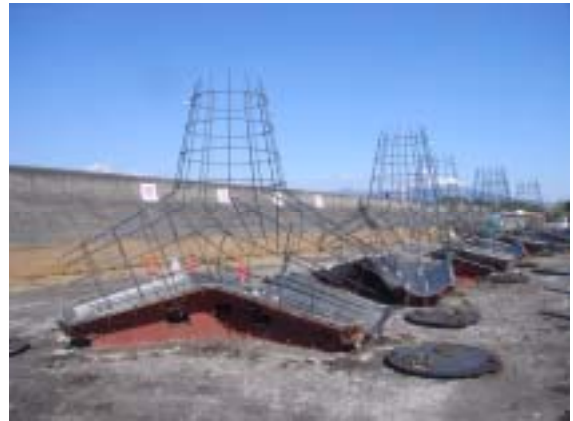
写真-5 鉄筋設置時の鉄筋の様子
