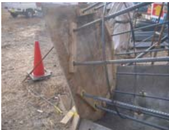
写真-3 脱着式の鉄筋差し込み定規(脚部)
