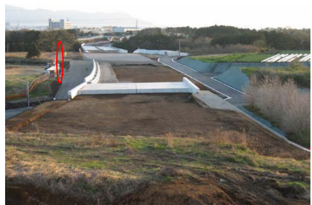
① 起点側 完成
