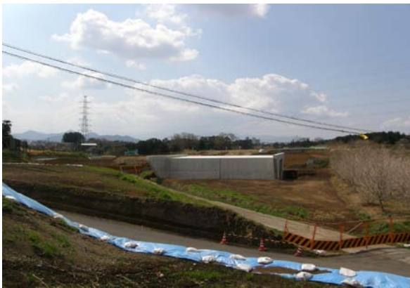
① 起点側 着工前
