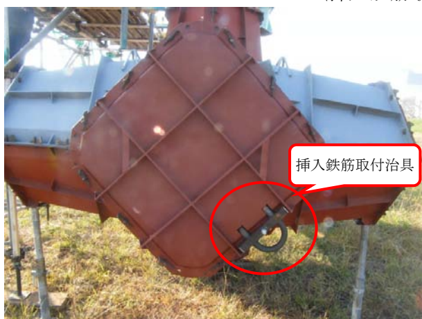
〈挿入鉄筋取付治具設置状況〉
