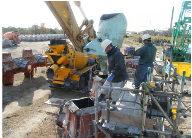
〈コンクリート打設状況〉
