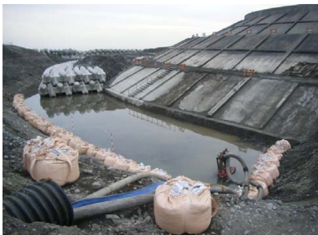
〈大型土のう設置状況〉
