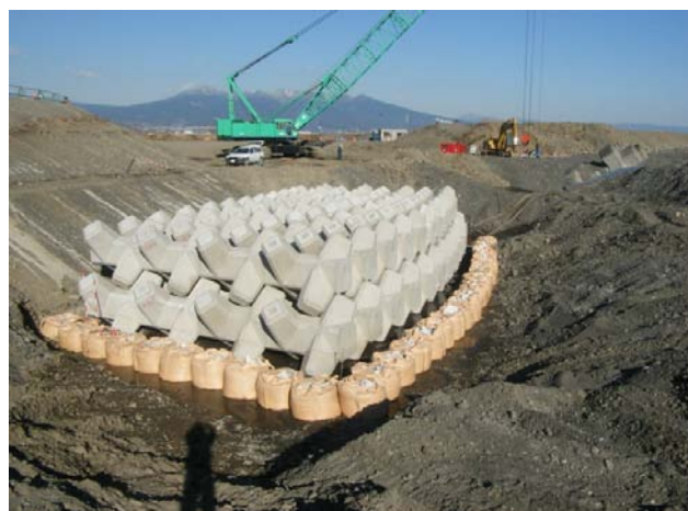
〈大型土のう設置状況〉
