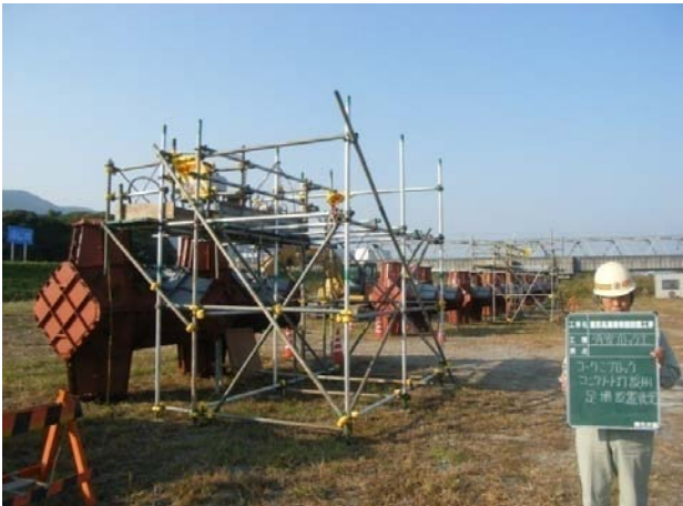
〈移動式足場設置状況〉
